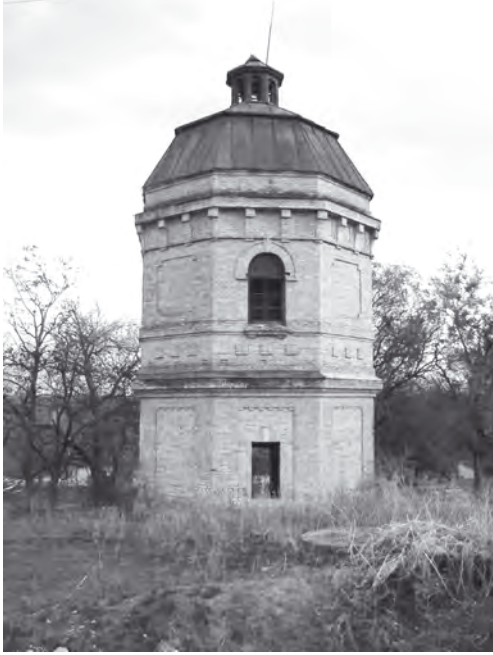
Селище Надіївка. Комплекс будівель залізничної станції Привільне, 1910-ті – 1929 рр. (водонапірна вежа)
