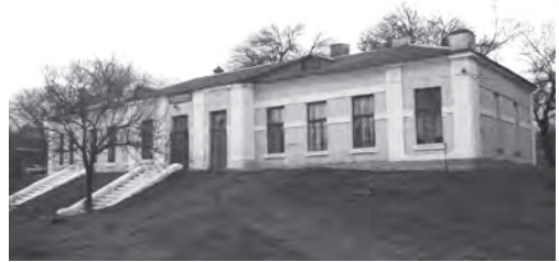
Селище Надіївка. Комплекс будівель залізничної станції Привільне, 1910-ті – 1929 рр. (будівля станції)
