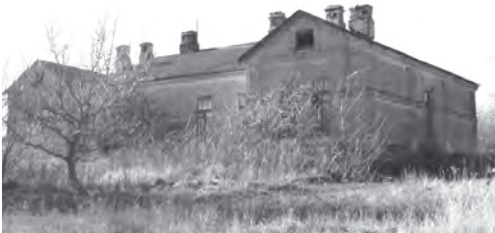
Селище Незабудине. Комплекс будівель залізничної станції Незабудине, I пол. 1910-х – 1929 рр. (житловий будинок)
