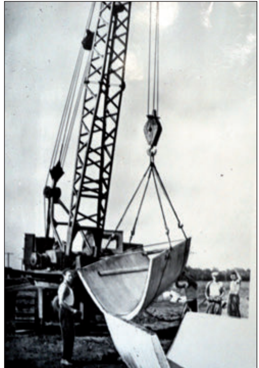
Будівництво зрошувальної системи біля с. Велика Костромка (1965 р.)
