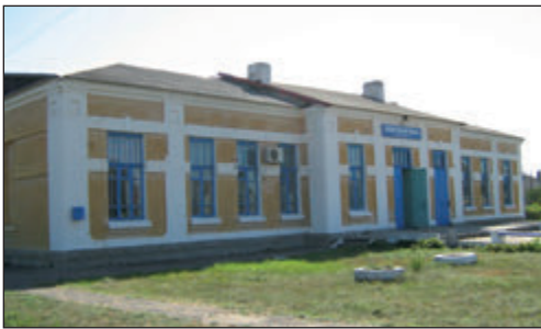
Станція Жовтокам'янка. Комплекс будівель залізничної станції Жовтокам'янка, 1910-ті - 1929 рр. (будівля вокзалу)
