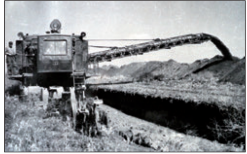
Будівництво каналу Дніпро - Кривий Ріг (с. Мар'янське, 1955 р.)
