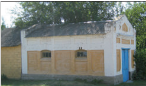
Станція Жовтокам'янка. Комплекс будівель залізничної станції Жовтокам'янка, 1910-ті - 1929 рр. (багажне відділення)
