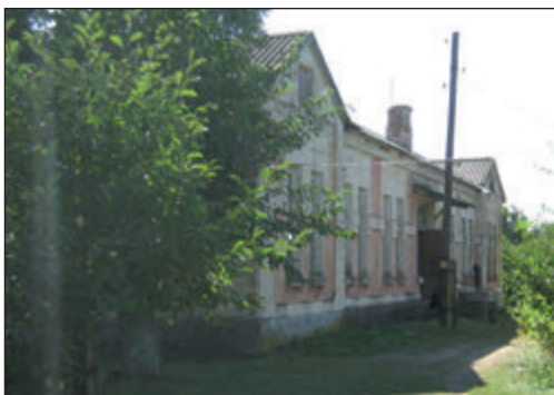
Станція Жовтокам'янка. Комплекс будівель залізничної станції Жовтокам'янка, 1910-ті - 1929 рр. (житло- вий будинок №1)
